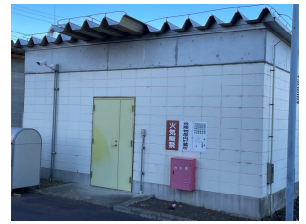
【危険物保管倉庫】
